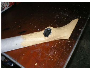
Słupek po ustawieniu otworu i nałożeniu szpachli
